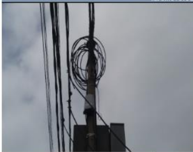
EMPALMADO PENDIENTE, FALTA CRUCETA (-11.107658, -77.710202) AV. 28 DE JULIO
