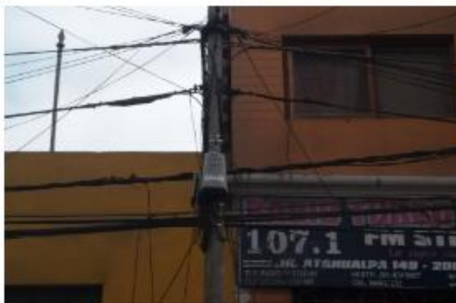
EMPALMADO PENDIENTE, FALTA CRUCETA (-11.107658, -77.710202) AV. 28 DE JULIO
