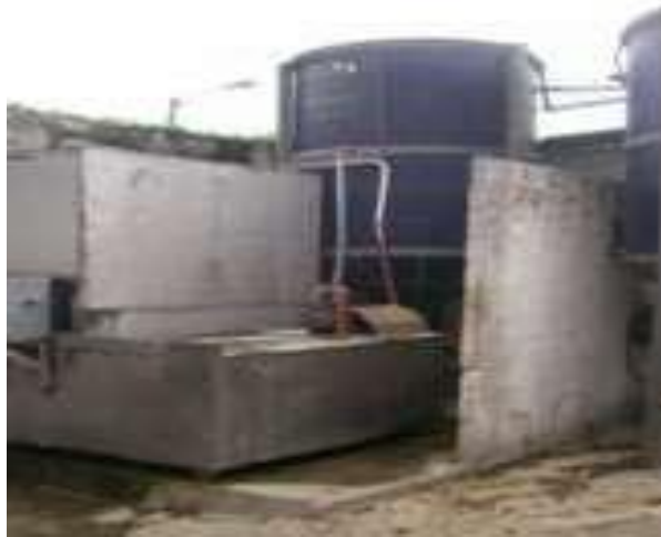
Figura N° 12 Área de la PTAR
