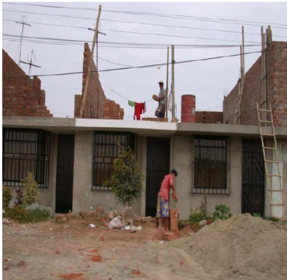
Figura 6: Continuando la construcción de la segunda planta
