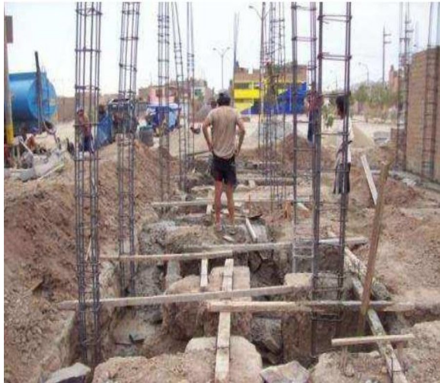
Figura 3: Zapata y columna armada
