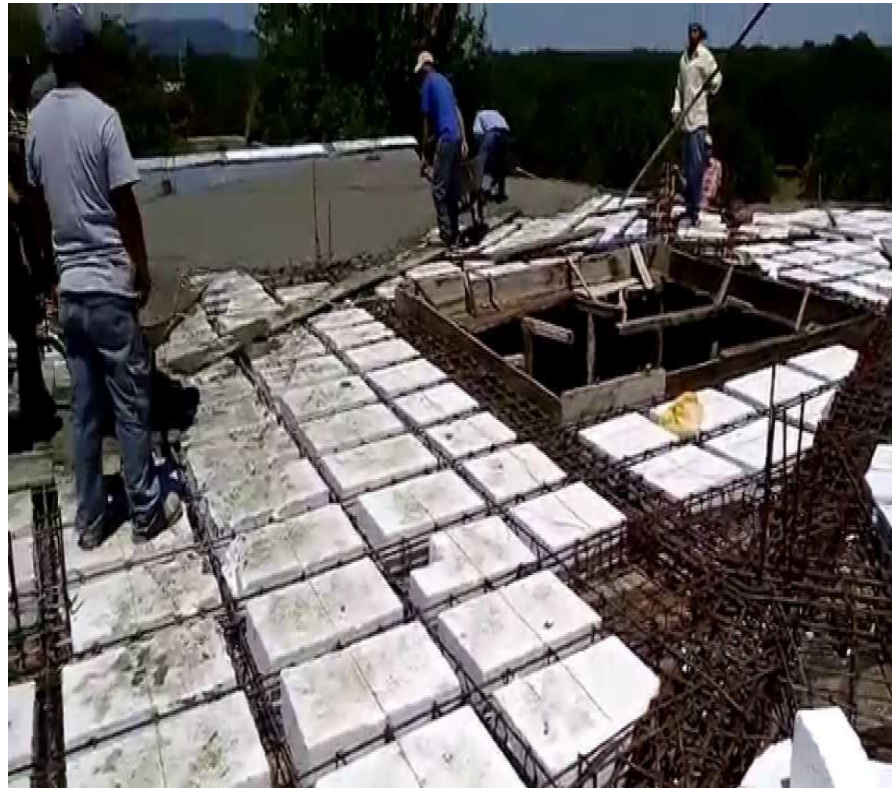
Figura 5: Preparado de la losa aligerada para su vaciado
