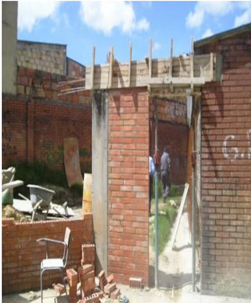
Figura 4: Armado de muros de fachada con columnas
