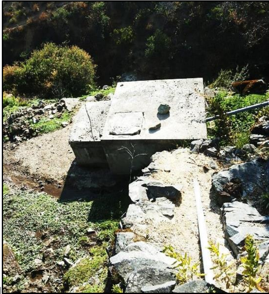
Figura 7. Vista superior del punto C1 (Captación de agua).
