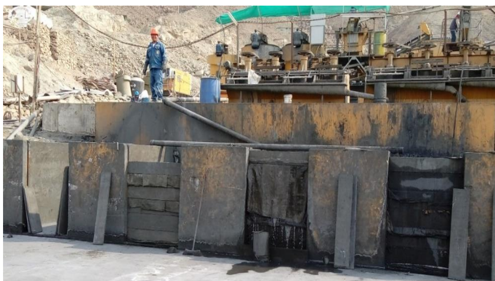
Figura N° 10: Banco de Celdas
