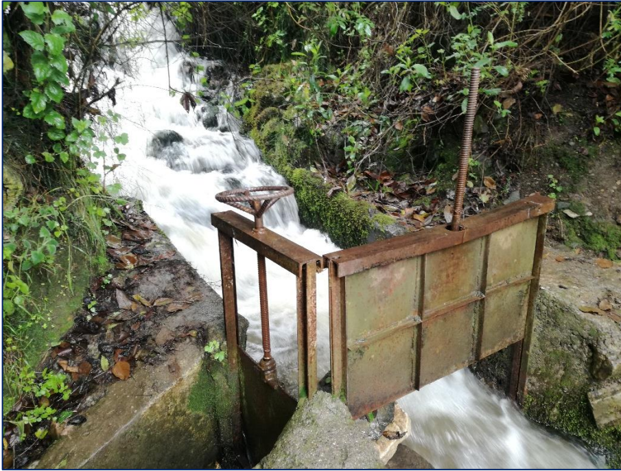
Fotografía N° 01: Véase la Captación Existente
