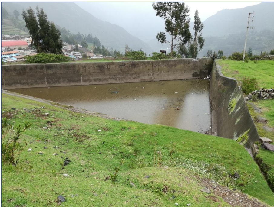
Fotografía N° 10: Véase el reservorio de concreto armado de forma triangular – fin del canal proyectado
