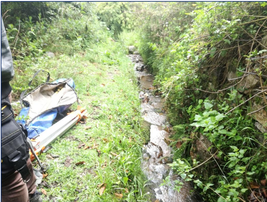
Fotografía N° 02: Véase el canal de conducción
