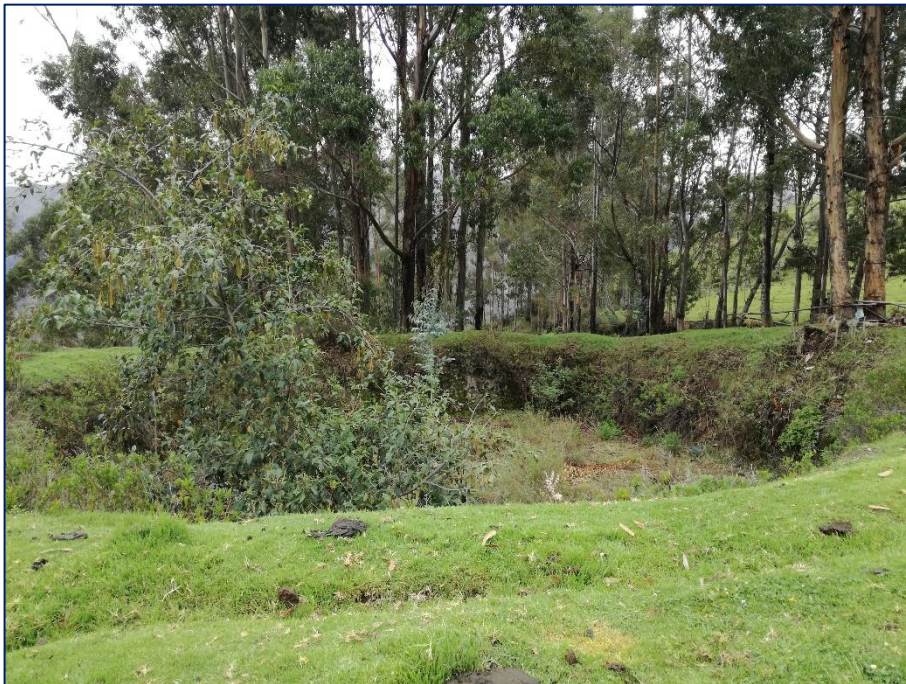
Fotografía N° 05: Véase el reservorio Circular de mampostería de piedra existente
