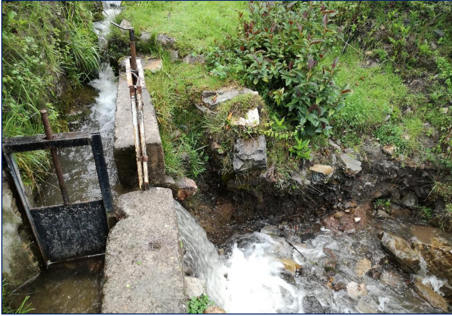
Fotografía N° 03: Véase la Toma lateral entrada al reservorio
