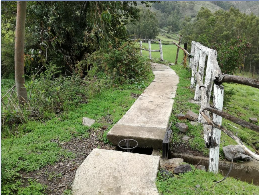
Fotografía N° 07: Véase la Alcantarilla existente para demolición
