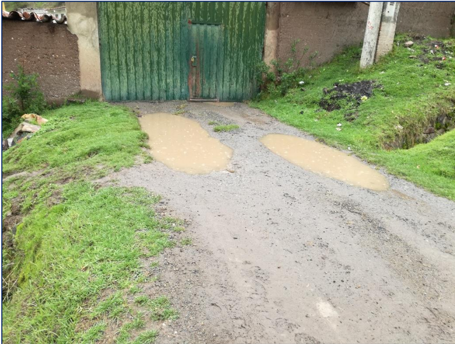
Fotografía N° 09: Véase la alcantarilla existente para demolición
