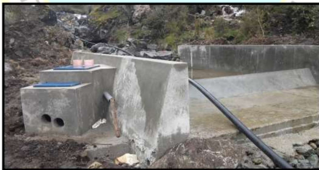
Figura 8. Vista general de bocatoma.
