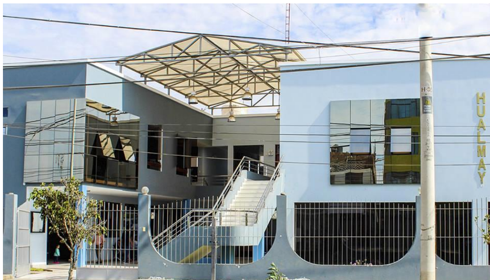
Figura 3. Fachada actual de la Municipalidad Distrital de Hualmay. (Fuente; página oficial de la Municipalidad de Hualmay).
