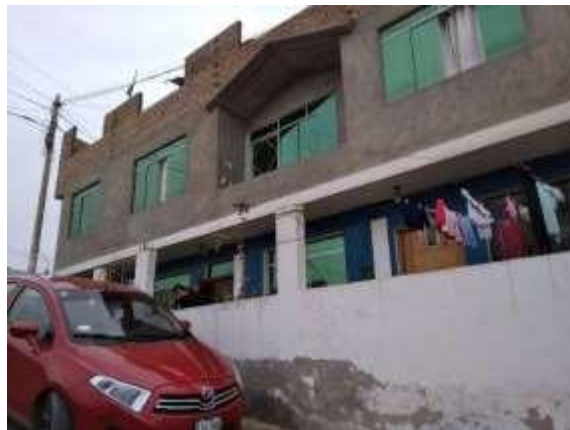
Figura N°16: Vivienda típica sin junta de dilatación
