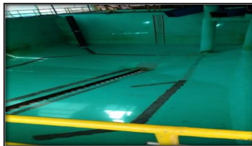
Figura 5. Tolva de almacenamiento
