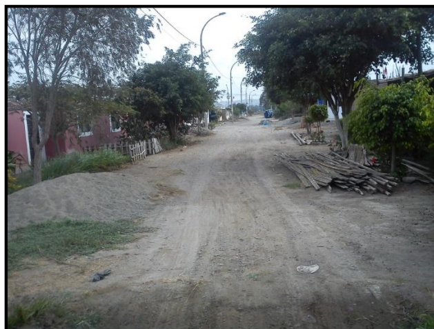
Figura 15: Situación actual de la calle Colonial, se aprecia gran cantidad de arbustos que invaden la vía pública.
