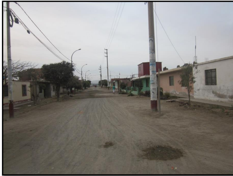
Figura 22: Viviendas característicos de la zona, además se aprecia las conexiones domiciliarias de luz y la res de alumbrado público.
