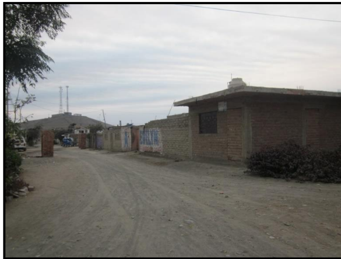
Figura 14: Situación Actual de la avenida imperial desde otra vista, se aprecia construcción de material noble en la gran mayoría de las viviendas.
