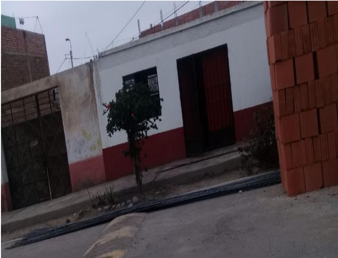
Figura 9: Acopio de ladrillo y fierro
