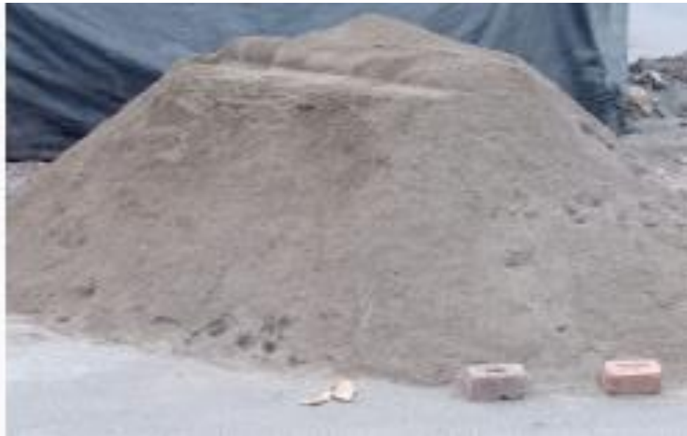
Figura 12: Acopio de arena gruesa
