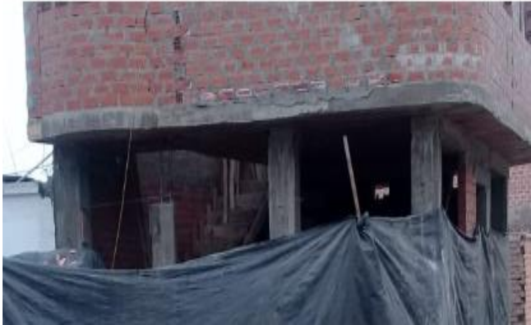
Figura 16: Construcción de la parte lateral izquierda
