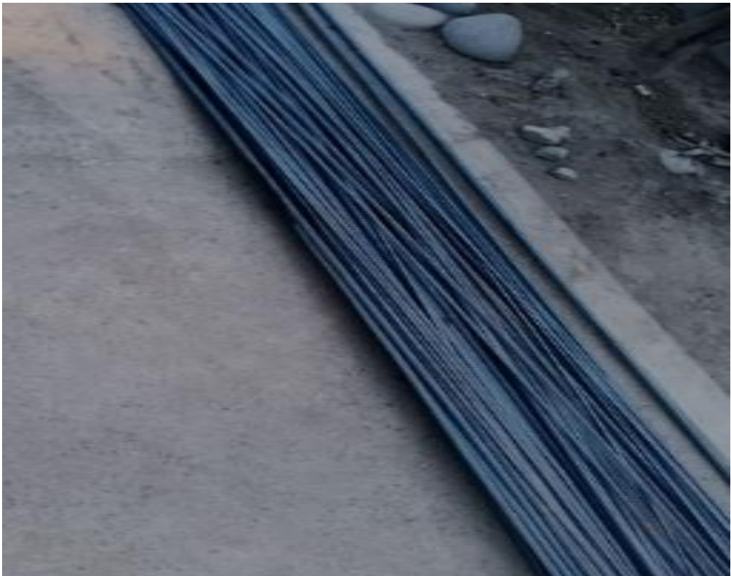
Figura 10: Acopio de fierro de diferentes medidas
