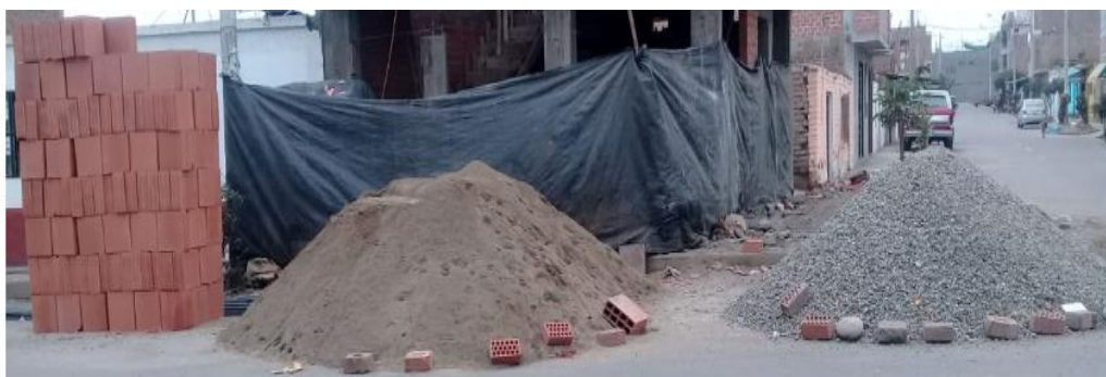
Figura 14: Materiales para ejecución
