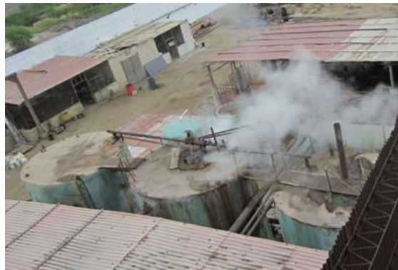
Figura 03: Tanques de almacenamiento
