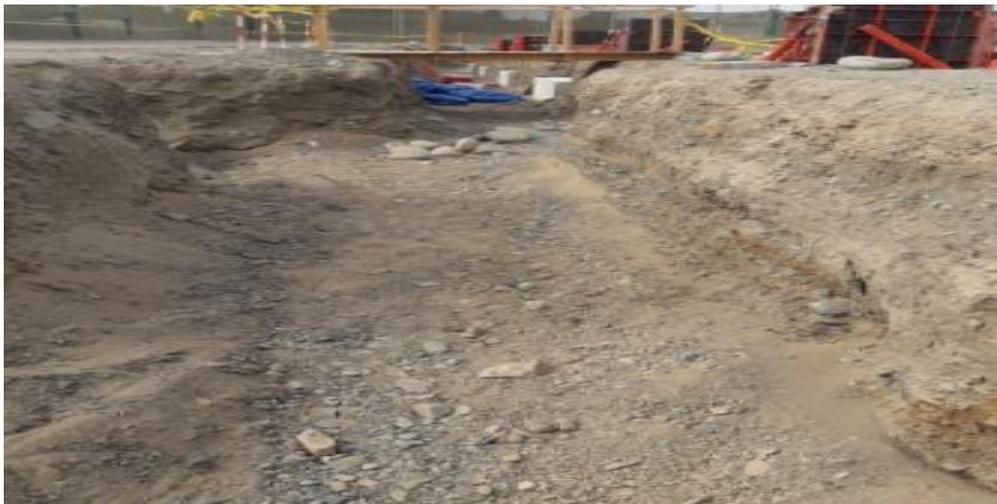
**Figura 4: Terreno excavado para extender malla**
