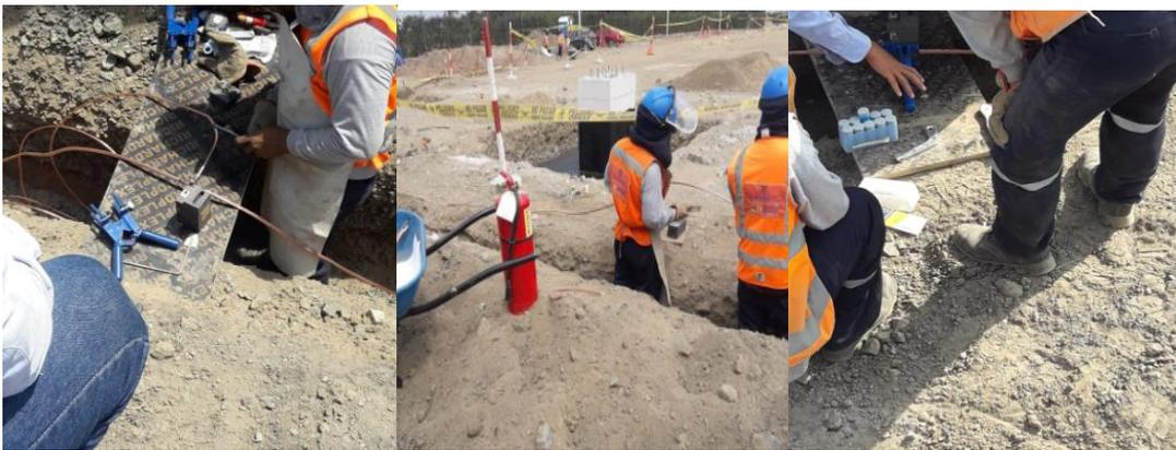
**Figura 3: Soldadura exotérmica de malla**
