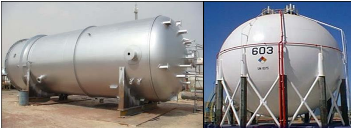
FIGURA N° 13: Recipientes a presión cilíndricos y esféricos
