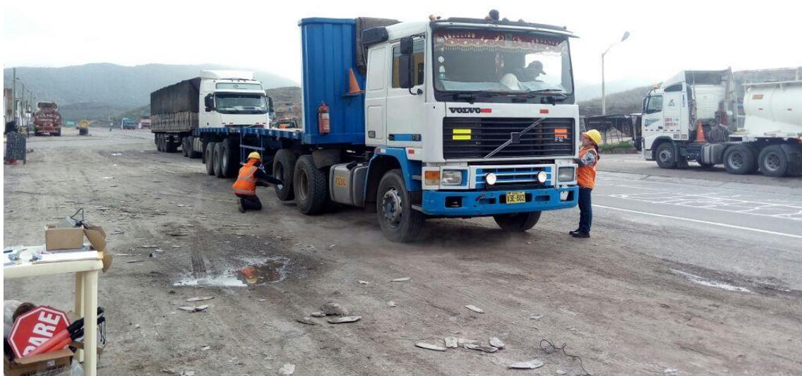
No hay espacio requerido para colocar las plataformas se tenía que colocar una cama de arena para la amortiguación de las plataformas en terreno pedroso, la balanza se colocó fuera de la vía de circulación como se observa en la foto.
