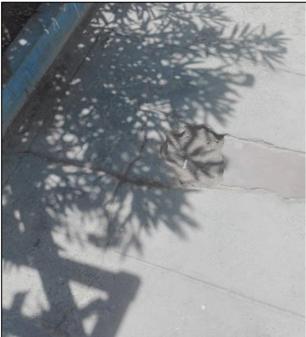
En la FIISI-I, se evidencia piso rajado con abertura.
