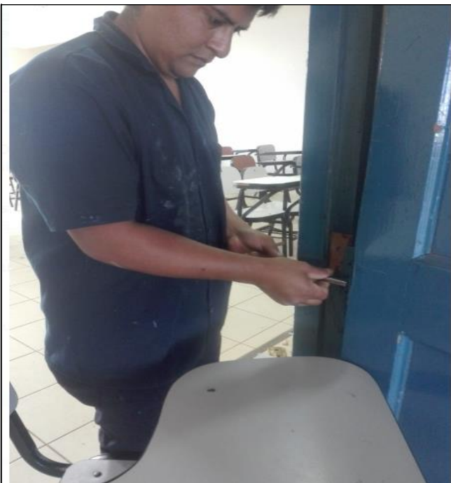
Personal de empresa contratista, realiza trabajos de cambio de chapas a las puertas de los salones de la FIISI-II, en condiciones inadecuadas.
