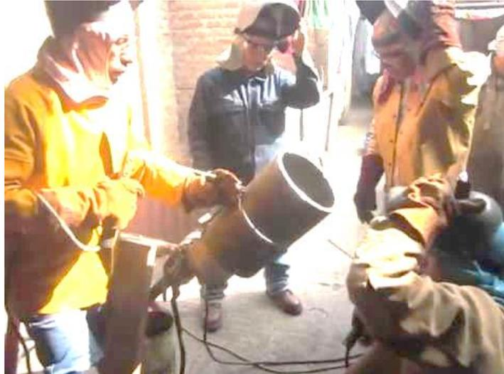
*Figura 25.* Proceso de soldadura – 6G.
