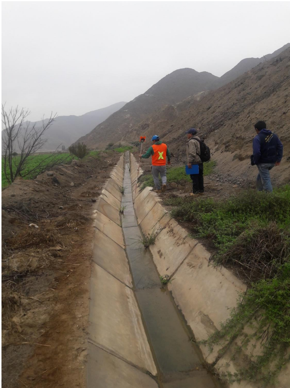
Figura N° 3: Levantamiento Topográfico de secciones de Canal
