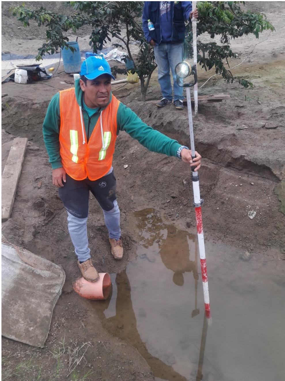
Figura N° 4: Levantamiento Topográfico de canal rústico.
