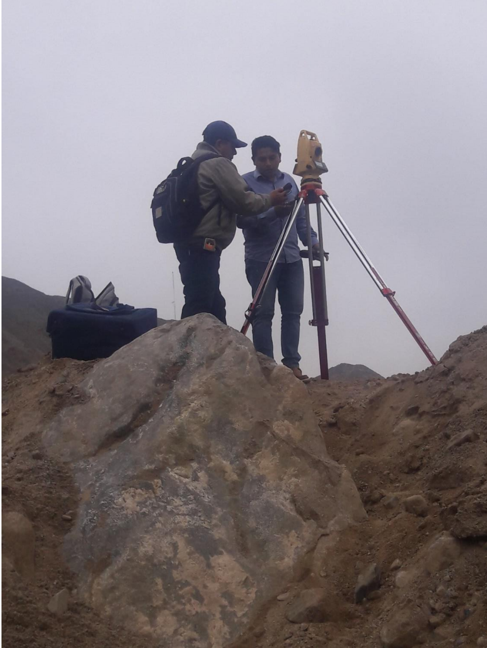
Figura N° 1: Colocación de la estación total para la medición del canal.
