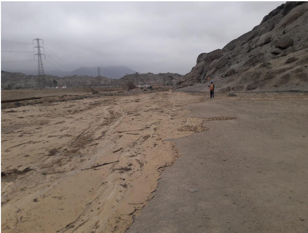
Figura N° 14: Rompimiento de cauce.
