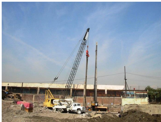
Figura 17. Unidad de vibroflotación.
