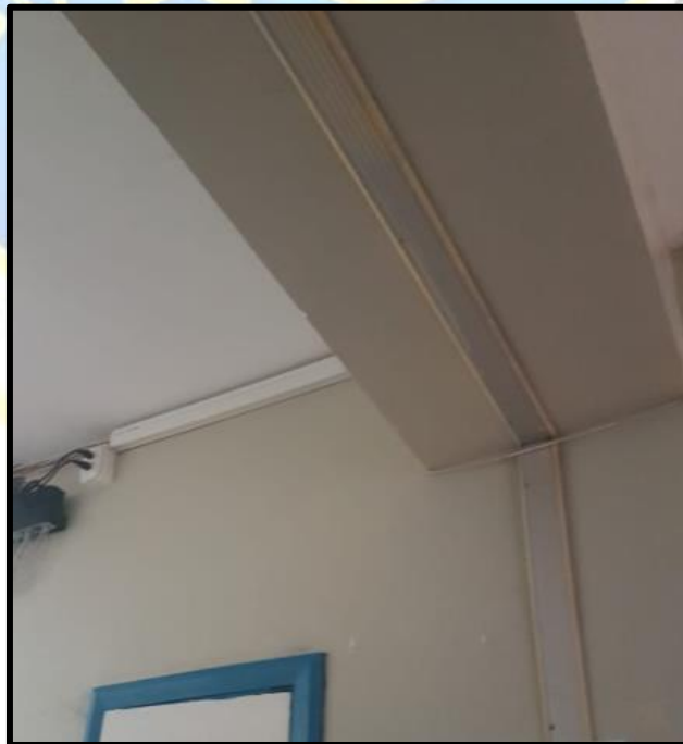
Figura N° 27: Junta de construcción - Vista interior (columna-viga)
