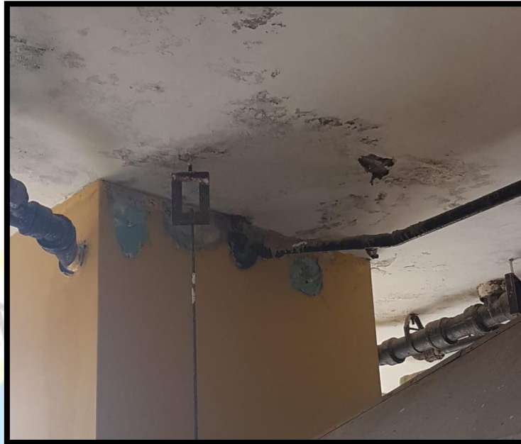
Figura N° 57: Instalaciones en elementos estructurales (vigas y columnas)
