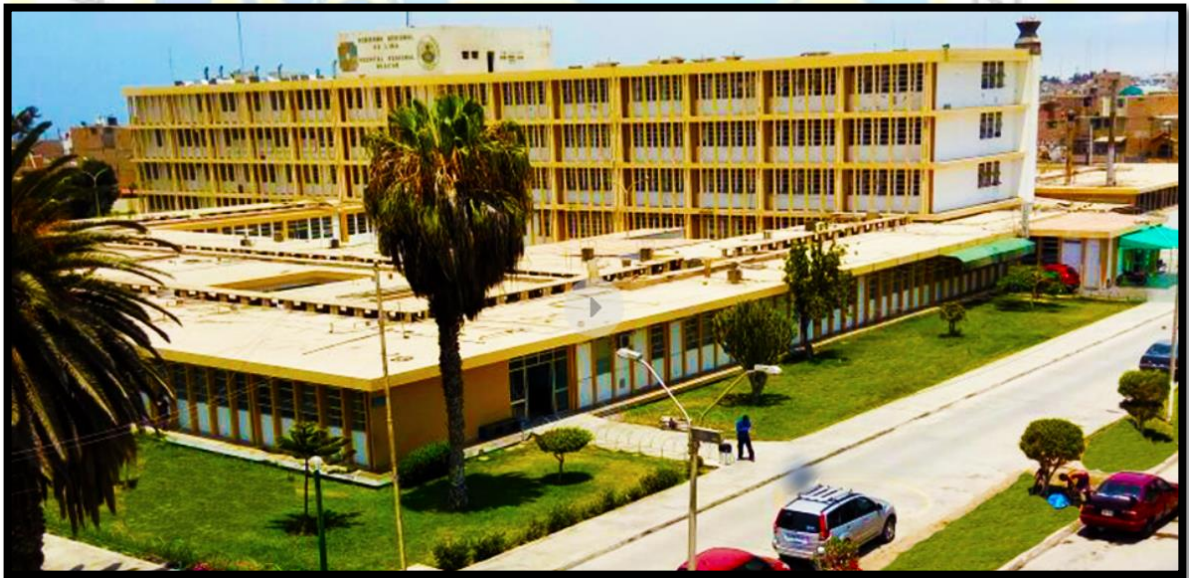
Figura N° 2: Módulo de servicios generales y hospitalización del Hospital Regional de Huacho
