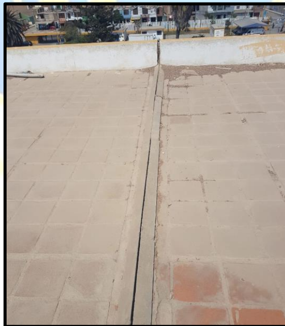
Figura N° 25: Junta de construcción - Vista exterior
