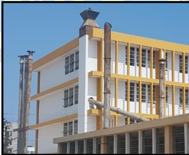
Figura N° 58: Instalaciones externas - columnas
