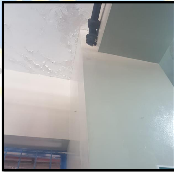
Figura N° 56: Instalaciones en elementos estructurales (columnas)
