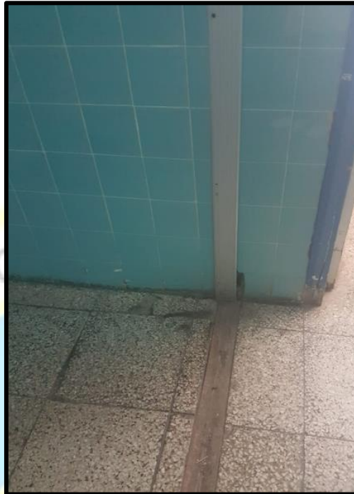
Figura N° 26: Junta de construcción - Vista interior (columna-piso terminado)
