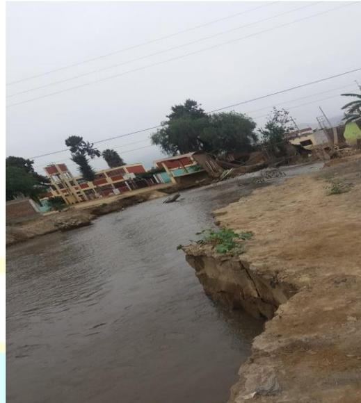
**Parte posterior de la vivienda que bloquea el paso del agua. El cauce en la parte posterior es sumamente estrecho para el volumen del agua.**
