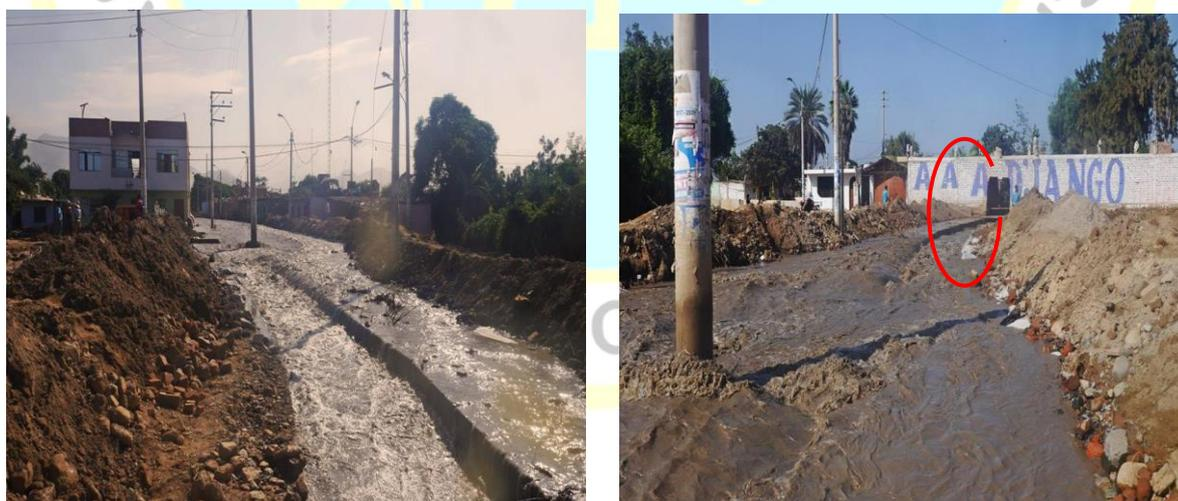
**Aumento del volumen del agua y obstrucción del cauce del Río Seco, se observa como la construcción de una vivienda en pleno cauce obstruye el paso del agua, generando luego que este colapse.**
