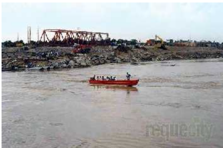
Figura 5 – Pasó de peatones en lancha (luego del Colapso del Badén)
