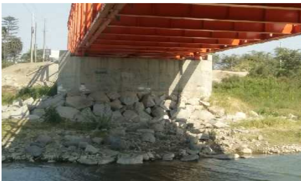
Figura 25 - Vista del Puente Reque – Pilar N.º 01
