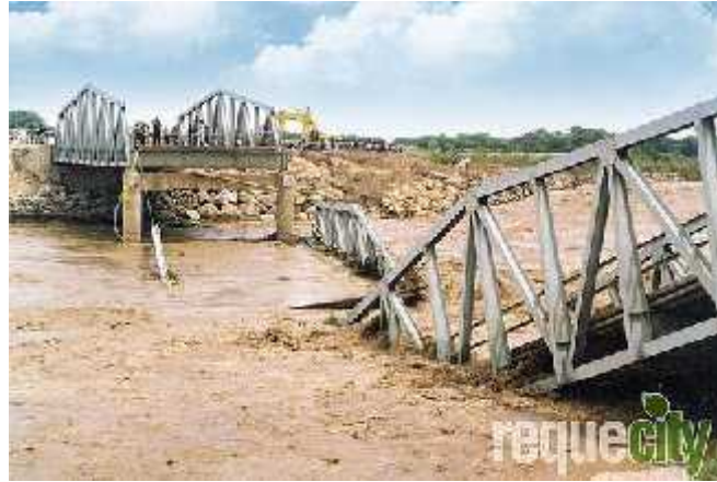
Figura 2 – Colapso del Puente Reque, Junio 1998
