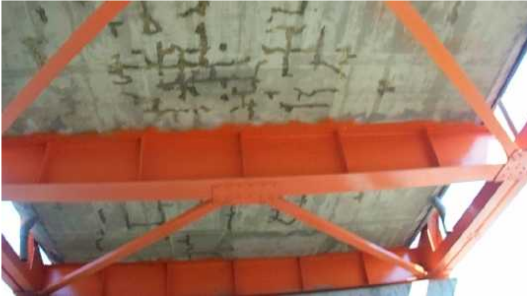
Figura 23 - Vista del Puente Reque
