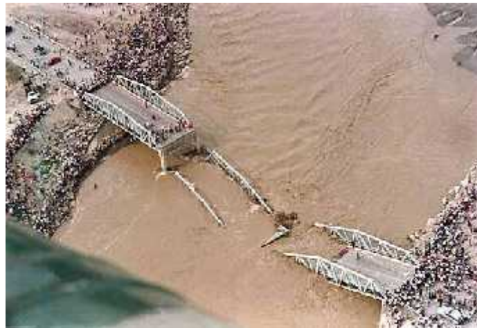
Figura 3 – Vista aérea del Colapso del Puente Reque, Junio 1998
