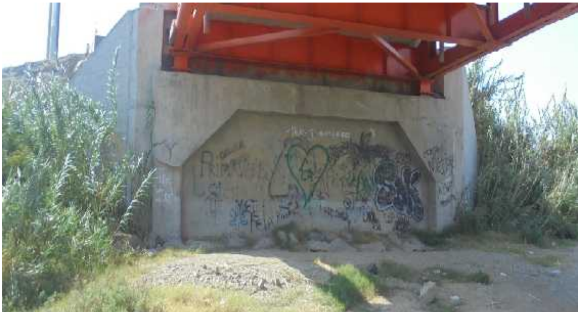
Figura 24 - Vista del Puente Reque – Estribo Derecho
