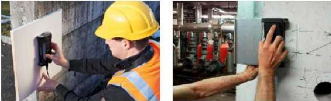
Figura 10 – Localización de Armadura
