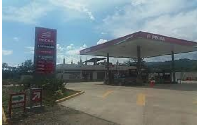
Figura 12. Estación de servicio grifo PECSA
