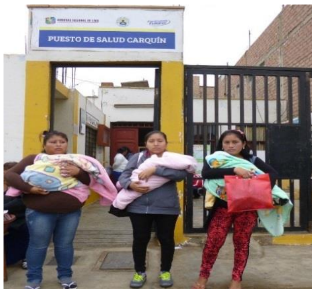
Figura 2. Posta médica de la caleta de Carquin
