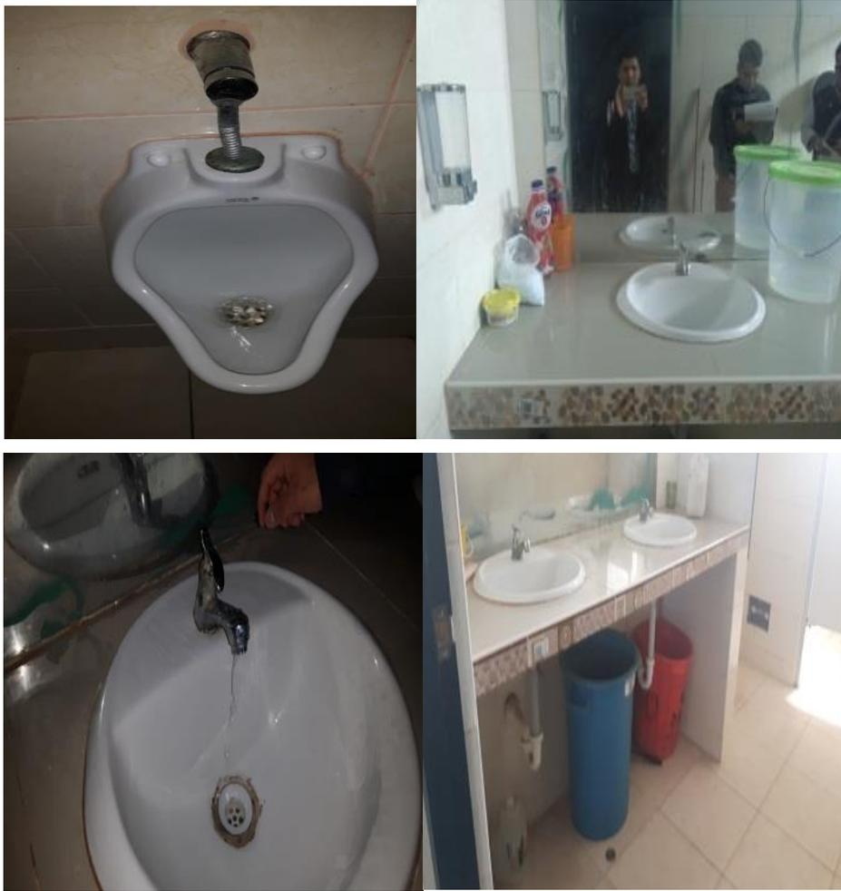
**Figura 48.** Fuga de agua en las instalaciones sanitarias de los baños.
