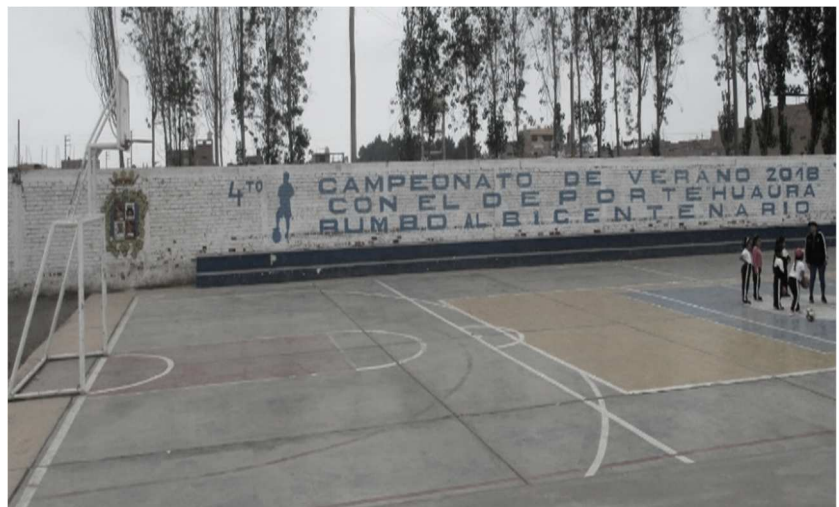
Figura 71. Losa deportiva - Call. Libertadores (Huaura)
