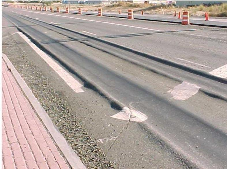
**Figura N° 12: Ejemplo de pavimento con rodera**
