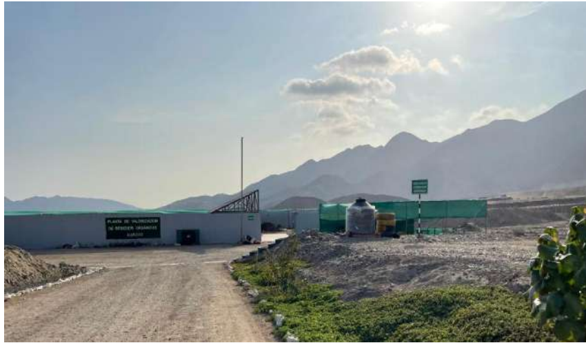
Figura 18. Planta de valorización de residuos orgánicos Huacho.
