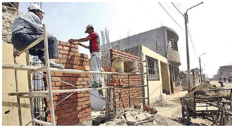
Figura 4: Muro de albañilería
