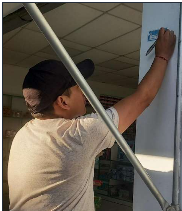
Figura 35. Colocación de sticker.
