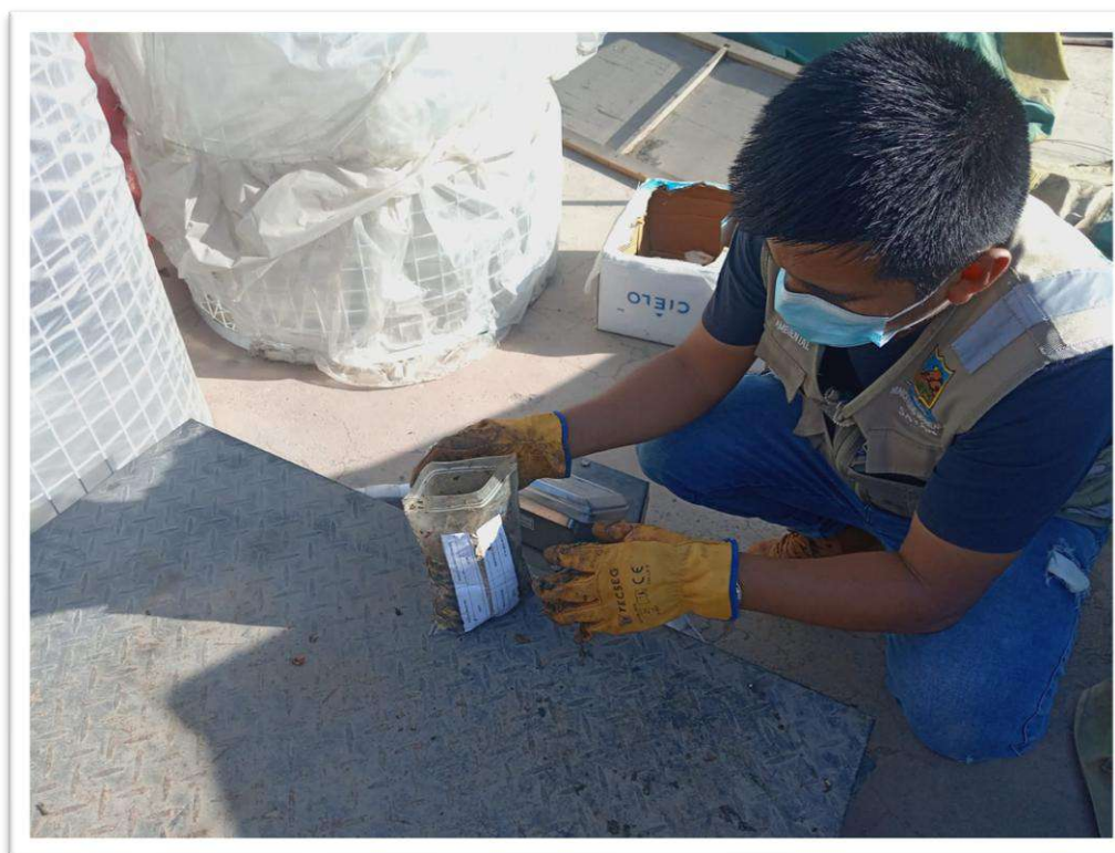
Figura 54. Extracción de muestras para análisis de humedad, distrito de Sayán. Elaboración propia.
