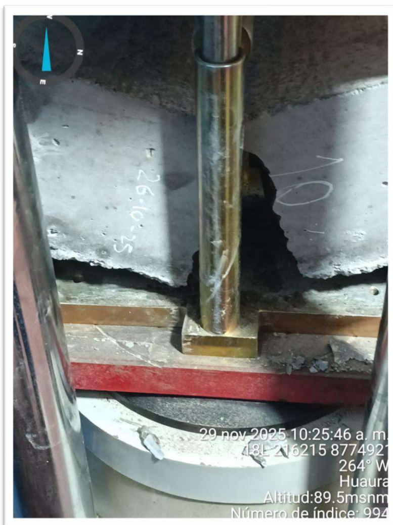
Imagen N° 17: Ensayo de flexión en vigas (28 días)
