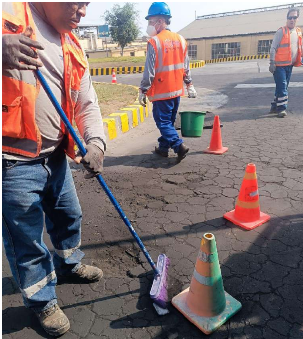
Figura 24: Verificación del orden y limpieza del área de trabajo
