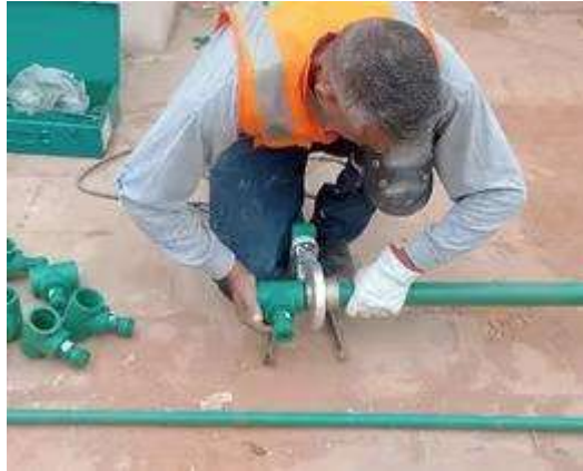
Grafica 12 Instalación de red de tuberías de agua Fuente: MR control soluciones sanitarias S.R.L.
