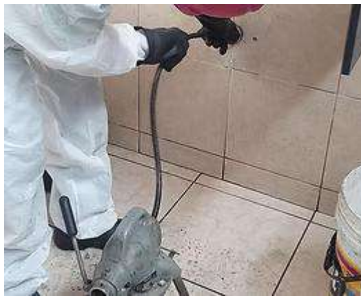
Grafica 13. Mantenimiento de tubería de desagüe Fuente: MR control soluciones sanitarias S.R.L.
