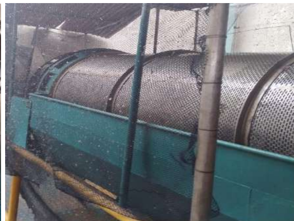
f) Vista interior del Desaguador Rotativo 2
