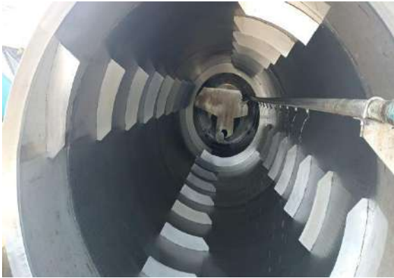
a) Parte interior del Trommel 0,5
