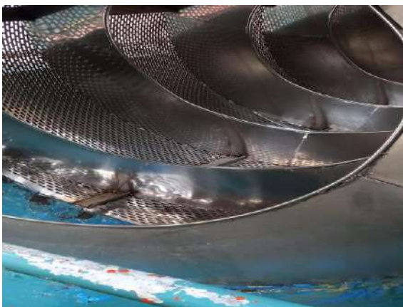
e) Vista interior del Desaguador Rotativo
