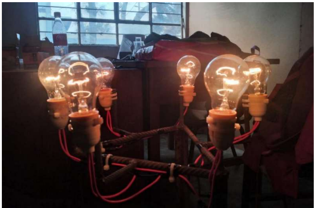
Figura 12. Instalación de las luces para el biodigestor
