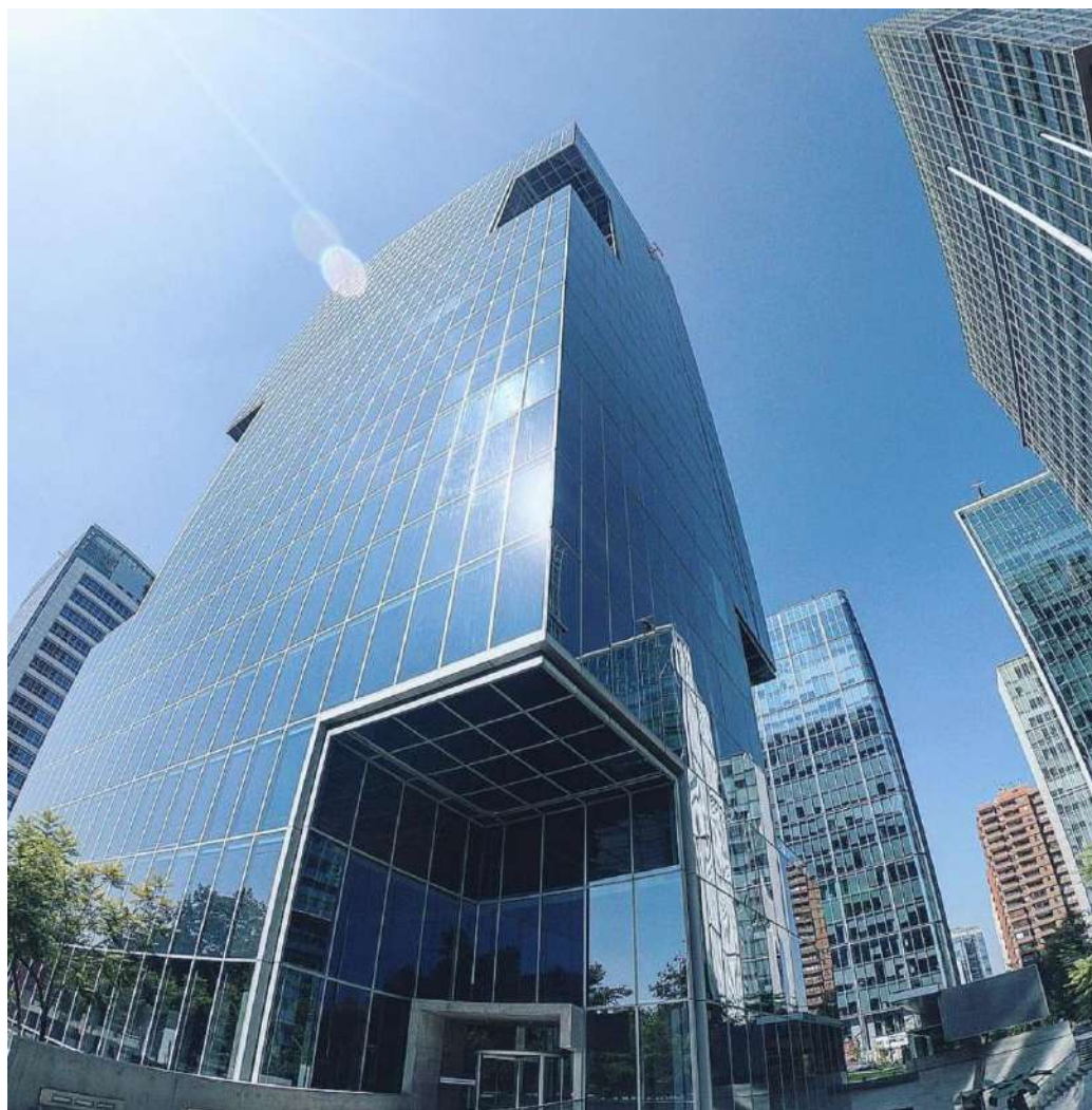
Anexo 10. Edificio Corporativo Banco Itaú Chile
