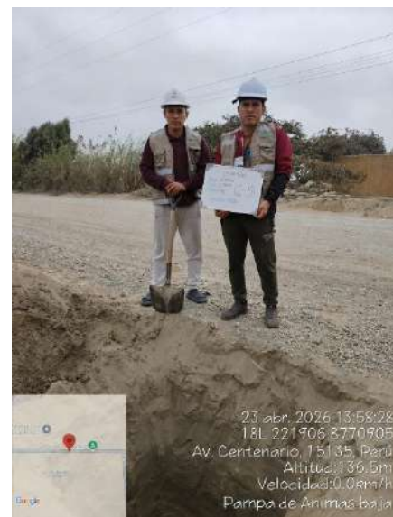
Foto 10: Fin de excavación de CLT-5.
