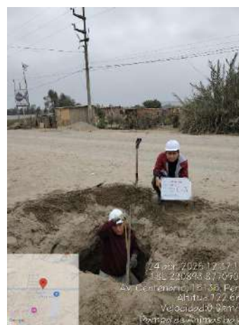
Foto 6: Fin de excavación de CLT-3.
