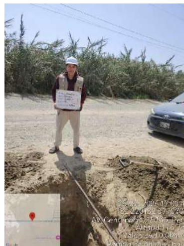
Foto 2: Fin de excavación de CLT-2.
