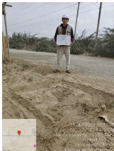
Foto 1: Inicio de excavación de CLT-1
