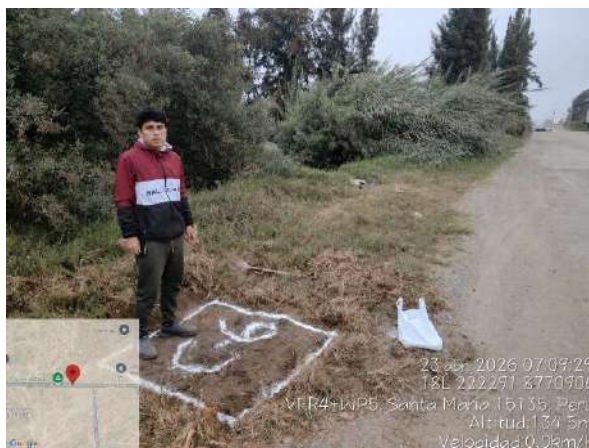
Foto 11: Inicio de excavación de CLT-6.
