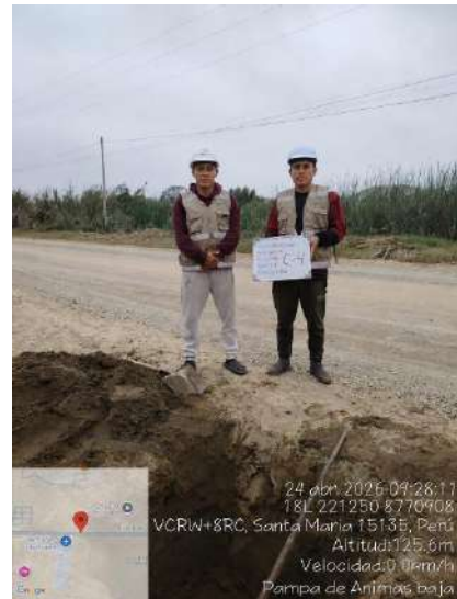
Foto 8: Fin de excavación de CLT-4.
