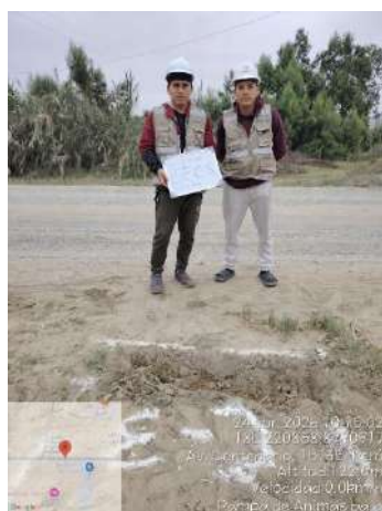
Foto 5: Inicio de excavación de CLT-3.
