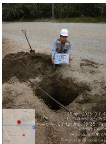
Foto 4: Fin de excavación de CLT-2.
