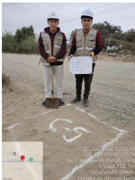
Foto 9: Inicio de excavación de CLT-5.
