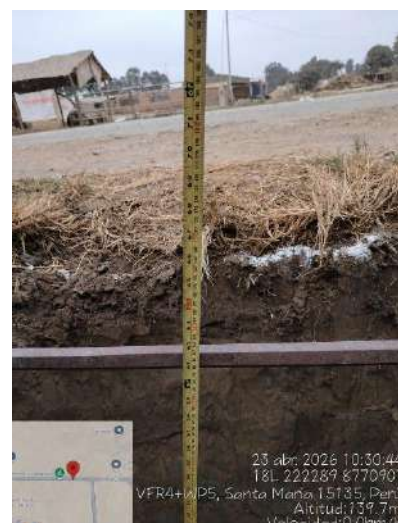
Foto 12: Fin de excavación de CLT-6.
