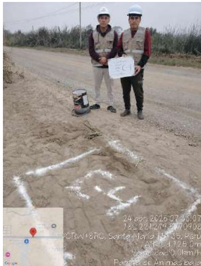
Foto 7: Inicio de excavación de CLT-4.
