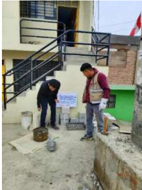
Foto 43: Trituración de residuos de concreto.
