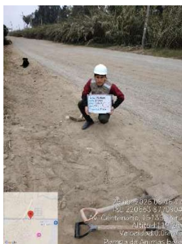
Foto 3: Inicio de excavación de CLT-2.
