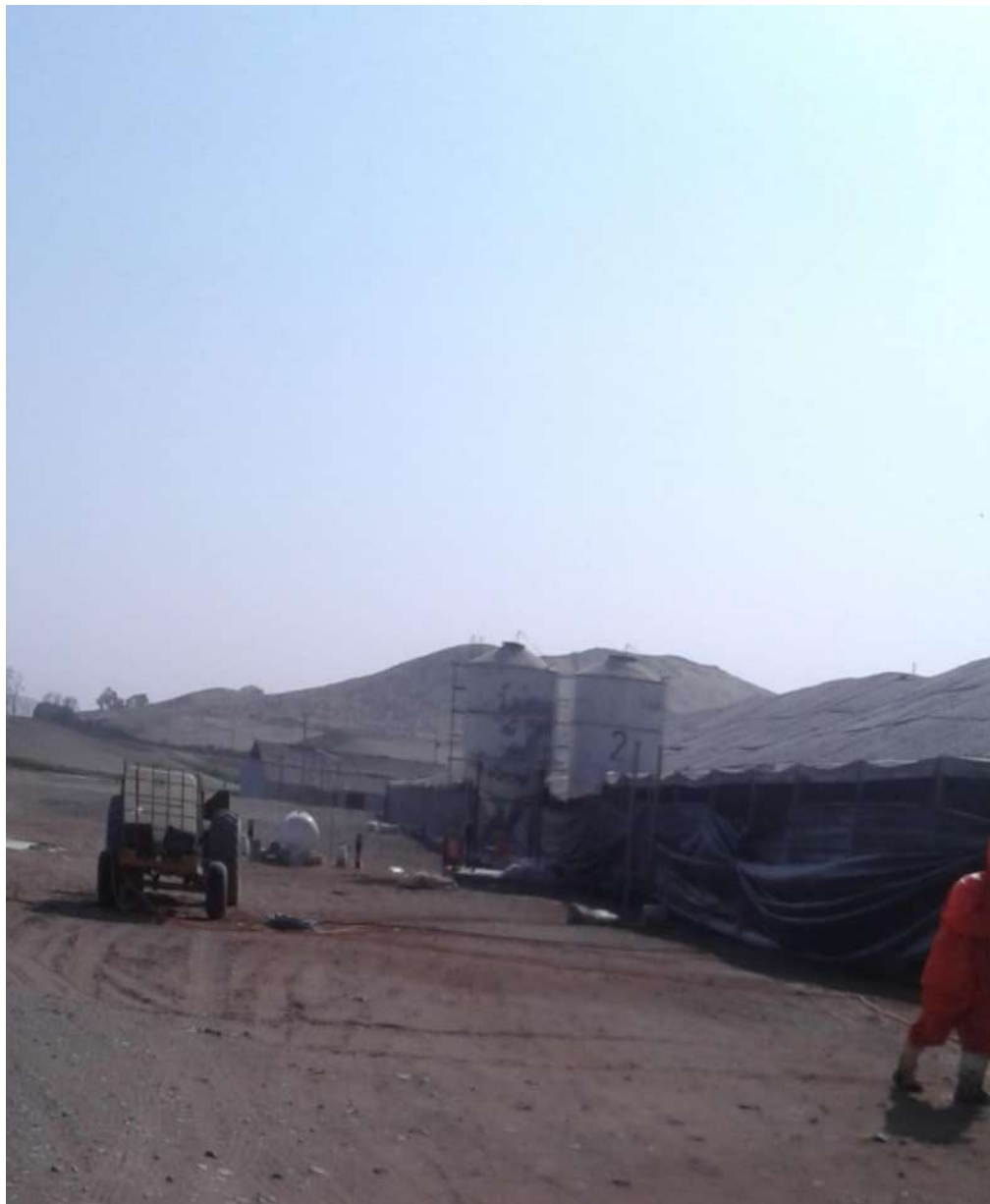
Lavado de silos
