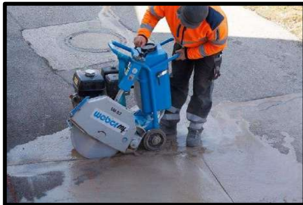
Figura 5: corte de juntas
