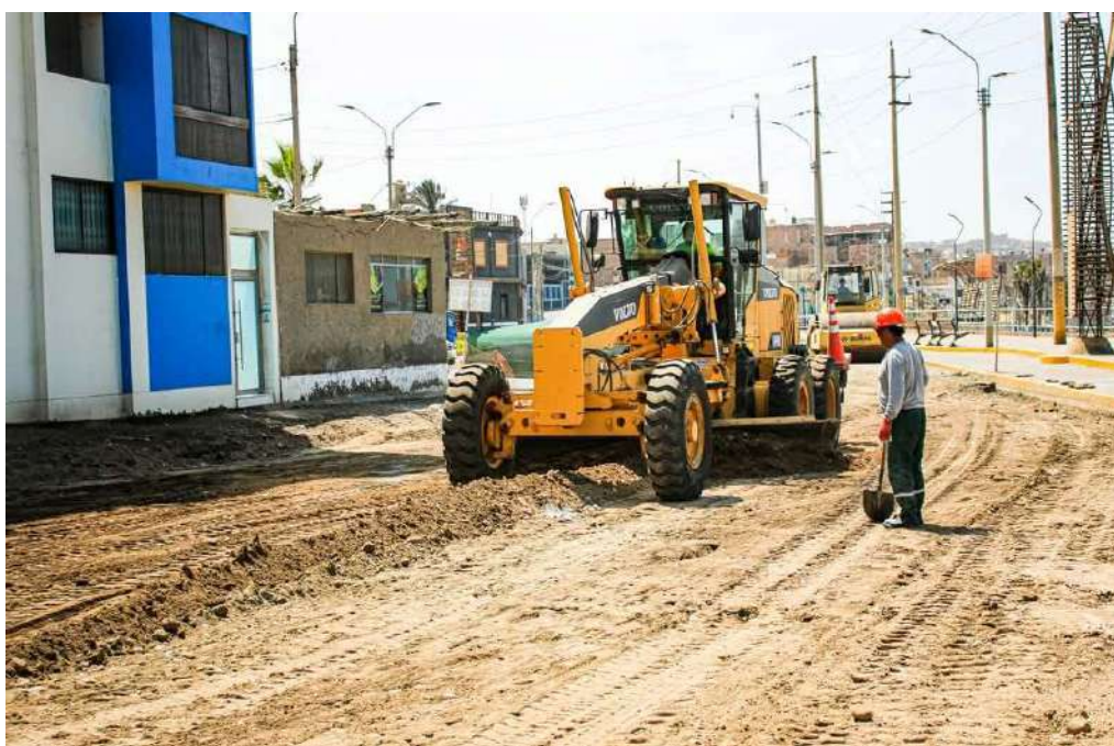
Av. 8 de octubre Huacho: Pvimentacion de pistas y veredas
