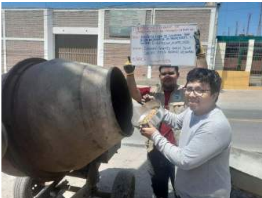
Fotografía N°24: Preparación y curado especímenes cilíndricos y vigas concreto (NTP 339.033)
