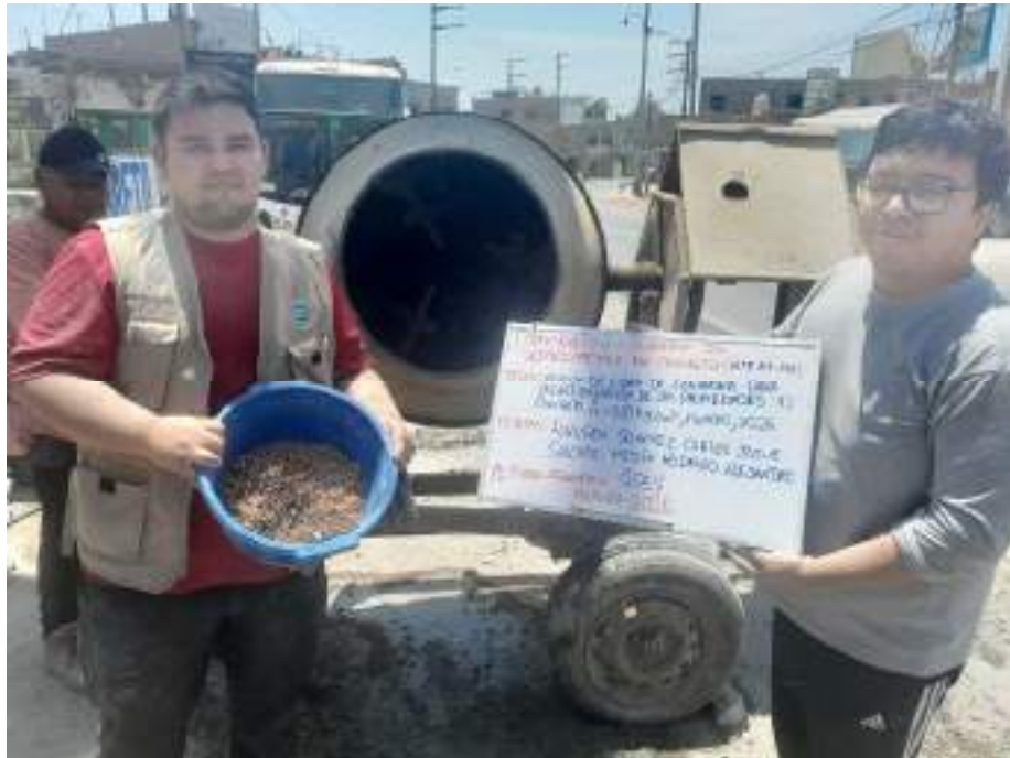
Fotografía N°21: Preparación y curado especímenes cilíndricos y vigas concreto (NTP 339.033)
