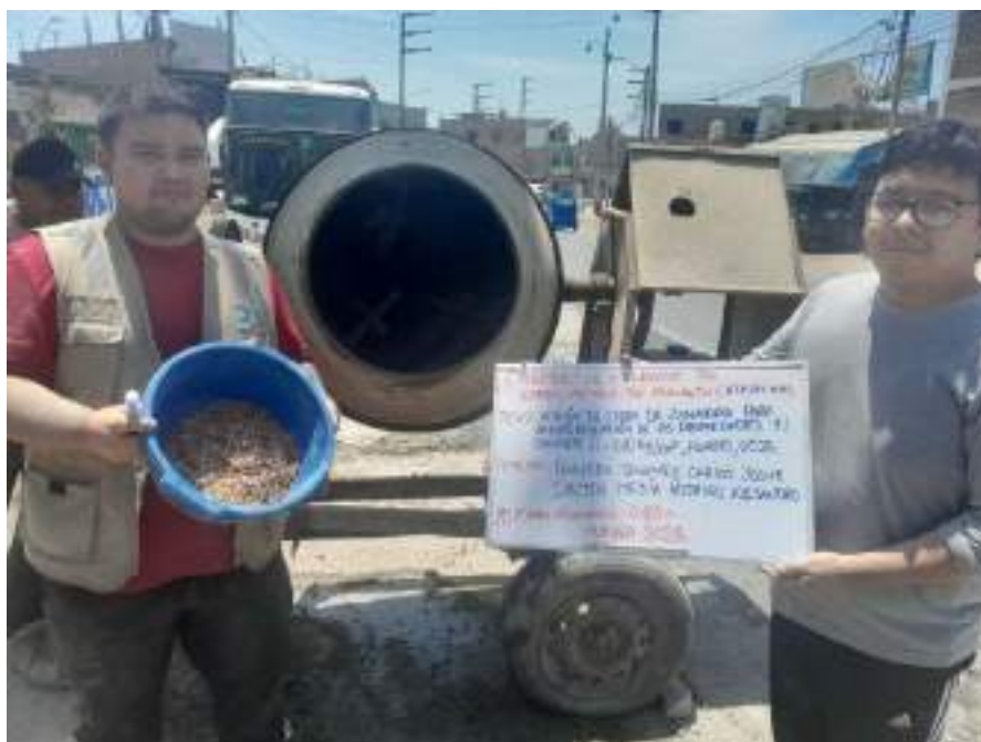
Fotografía N°22: Preparación y curado especímenes cilíndricos y vigas concreto (NTP 339.033)
