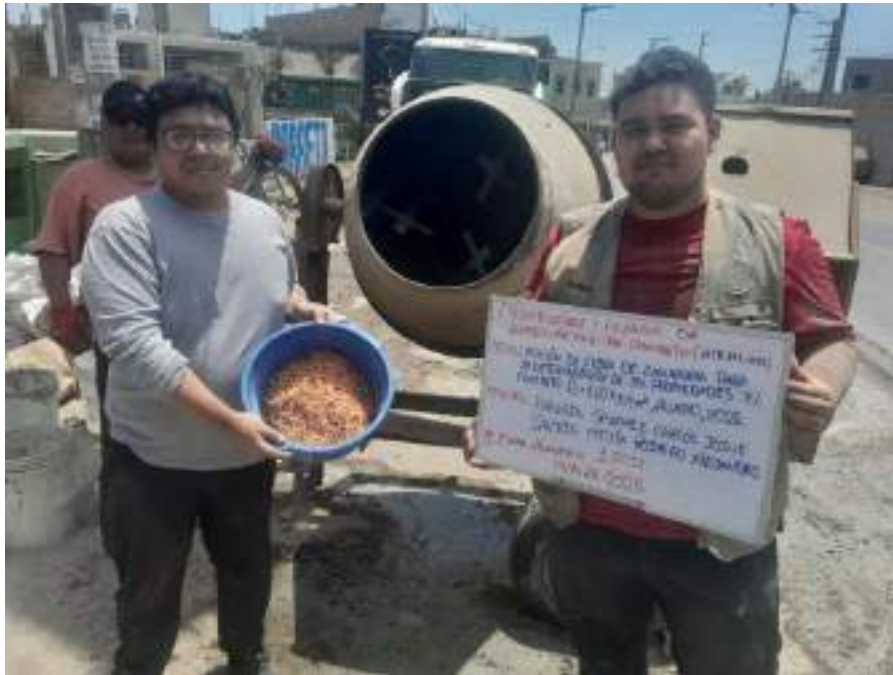
Fotografía N°23: Preparación y curado especímenes cilíndricos y vigas concreto (NTP 339.033)
