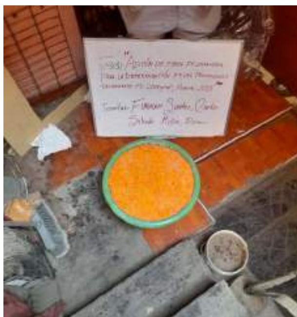
Fotografía N°4: Tratamiento del aditivo con cal muerta
