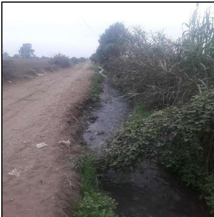
Figura 6: Se observa el canal de tierra pendiente de diseño y construcción
