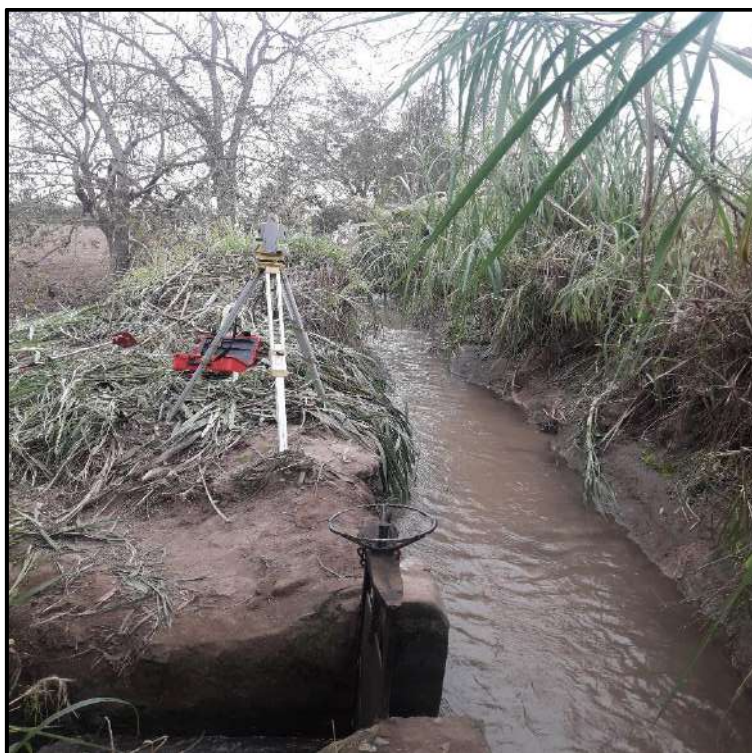
Figura 1: Se observa realizando la topografía del canal Miraflores
