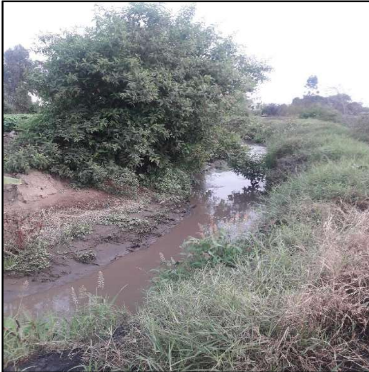
Figura 5: Se observa el canal de la cota +2000.00 lleno de malezas
