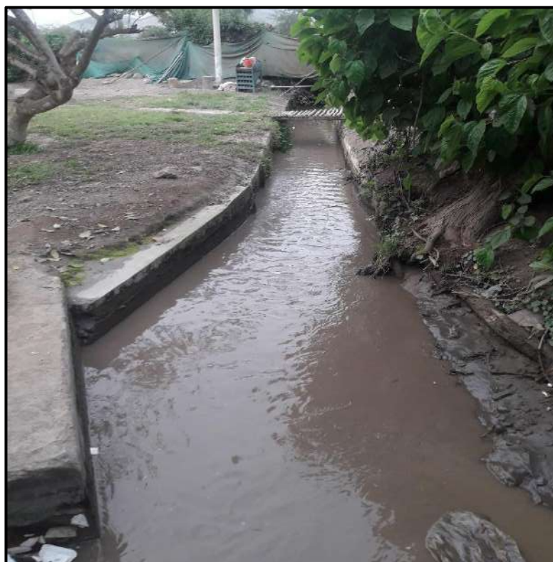
Figura 2: Se observa donde inicia el canal para su ejecución
