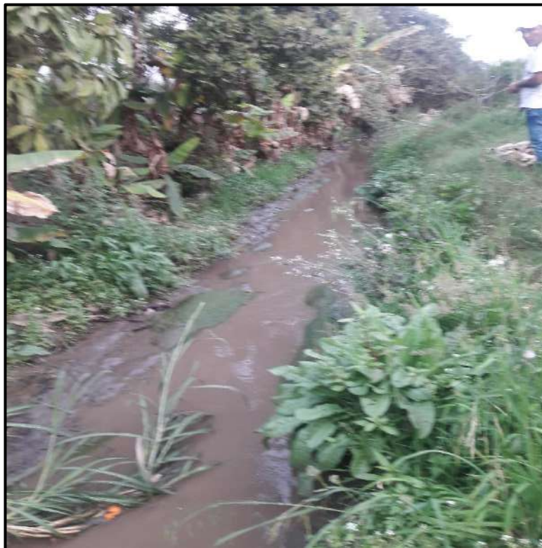
Figura 4: Se observa el canal saturado de residuos no hay fluido del agua
