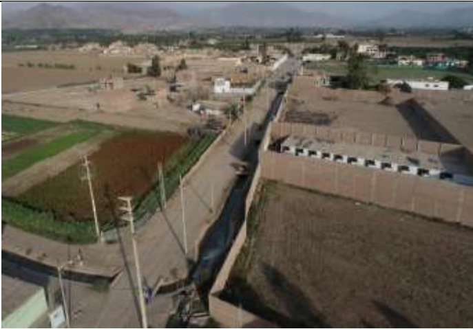
Vista tomada por drone del canal L1 Cañón 1
