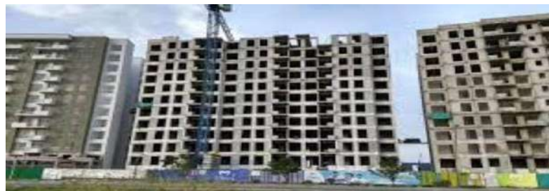
Figura N°13: Edificio construido con sistema estructural dual.
