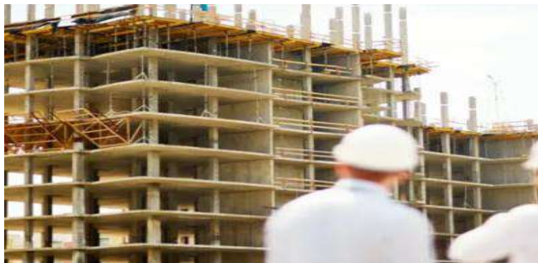
Figura N°15: Edificio construido con sistema estructural dual.
