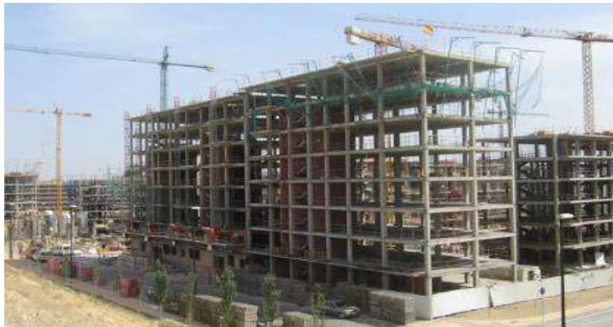
Figura N°14: Edificio construido con sistema estructural dual.
