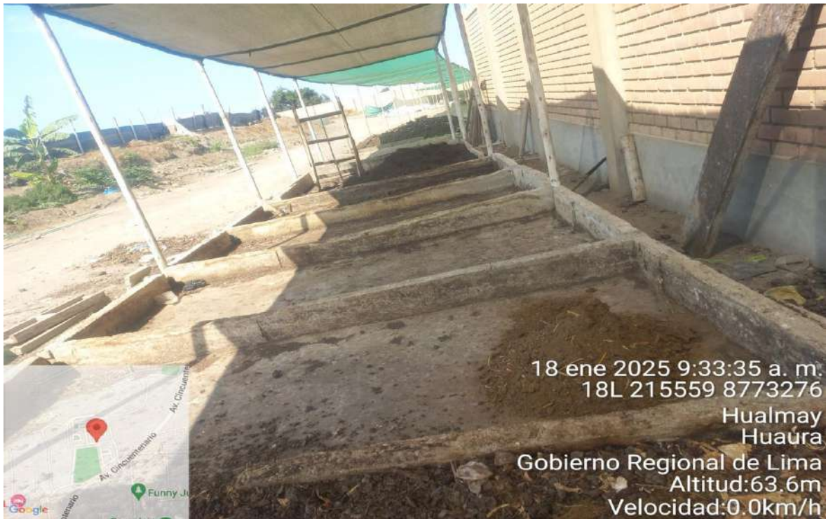
Figura 33. Inicio del Armado de las camas para el compost del Bloque 03.
