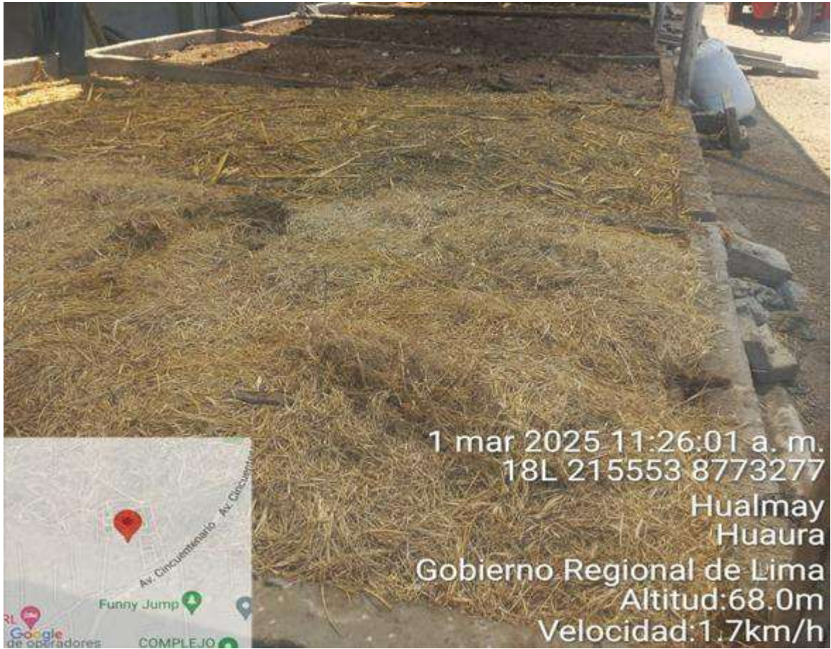
Figura 34. Sellado de las camas de compost del Bloque 03.
