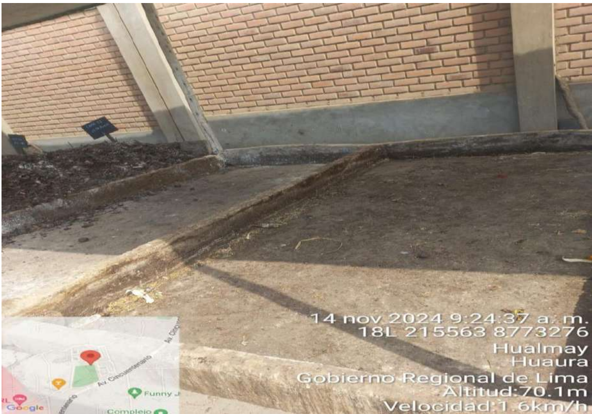
Figura 31. Inicio del Armado de las camas para el compost del Bloque 02.
