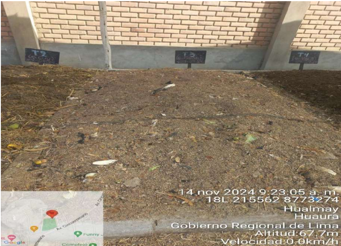
Figura 30. Sellado de las camas de compost del Bloque 01.
