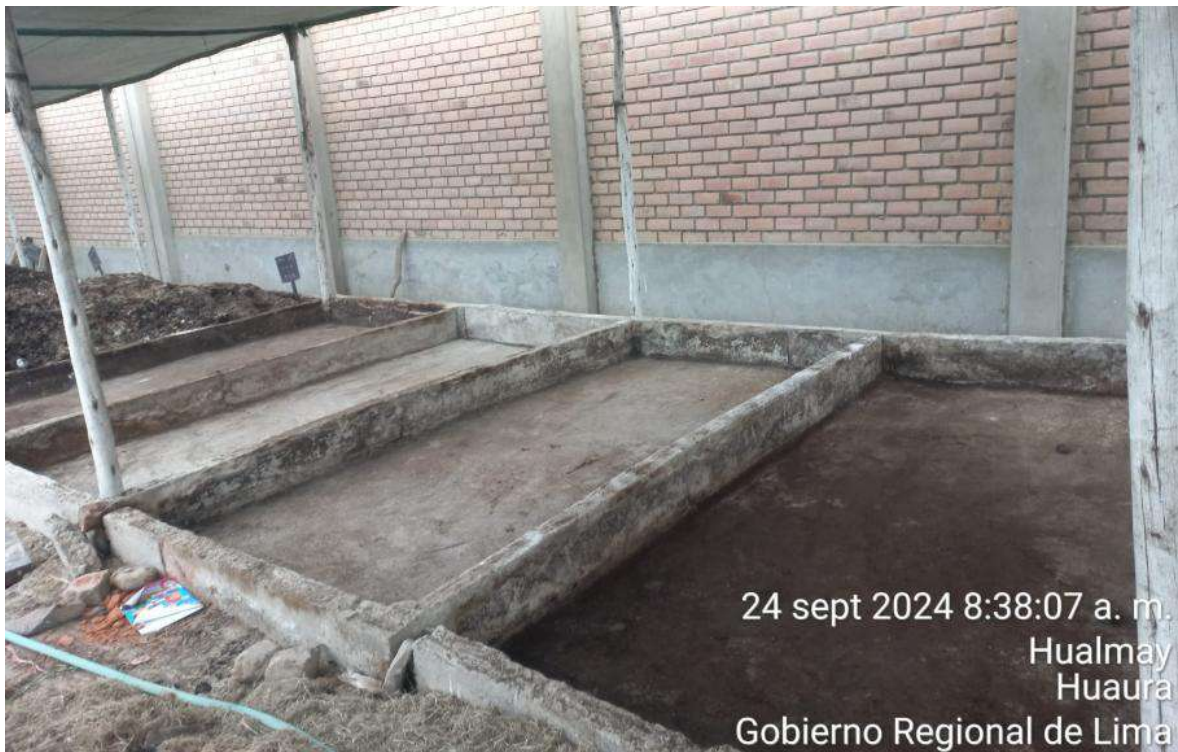
Figura 28. Inicio del Armado de las camas para el compost del Bloque 01.
