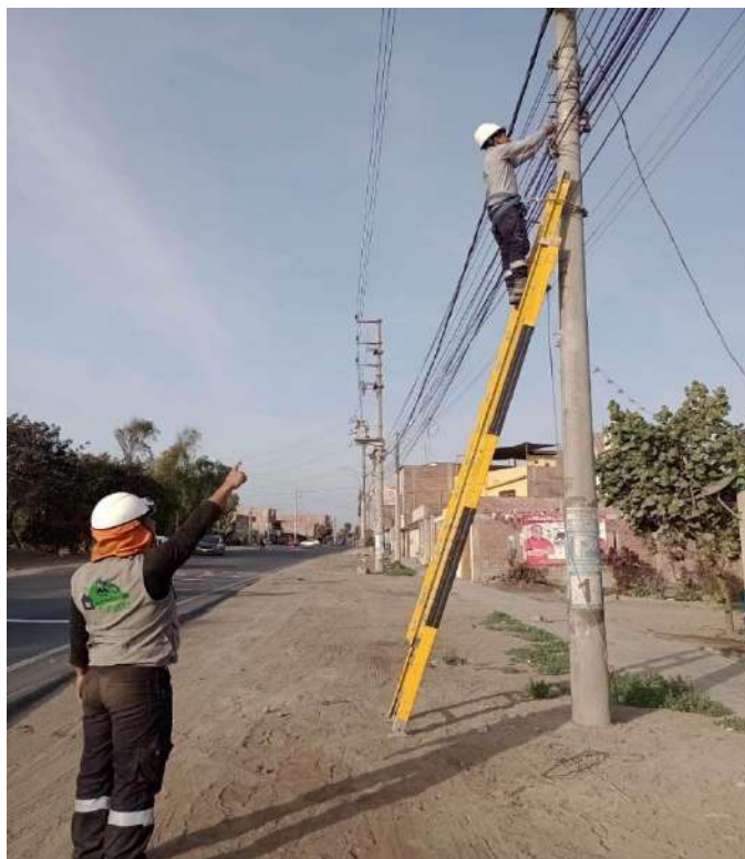
Figura 3: validando las conexiones y el tipo de tendido
