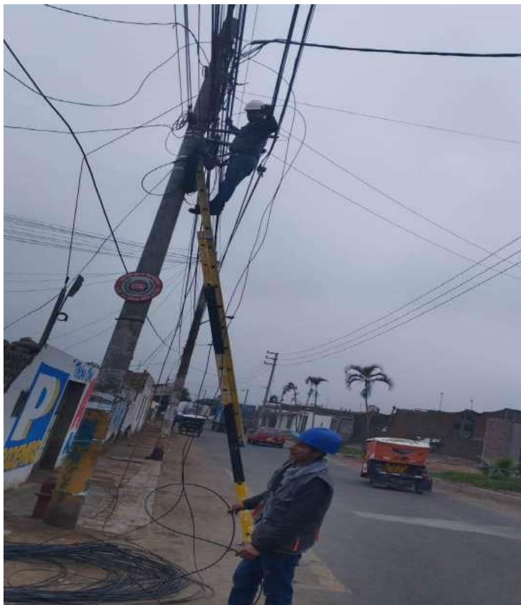
Figura 5: Tendido de fibra óptica en la zona de Quepepampa
