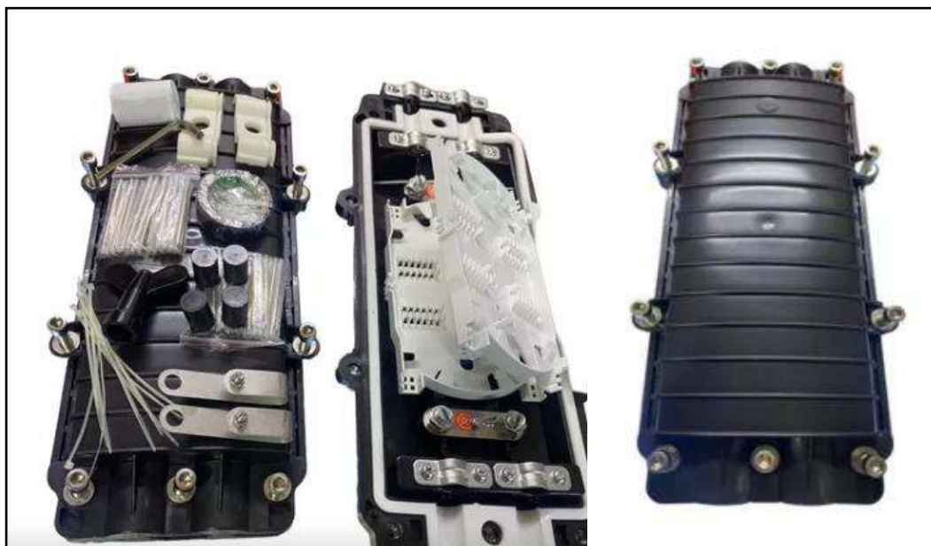
Figura 21. Mufas para proteger puntos de fusión en fibra óptica en redes externas
