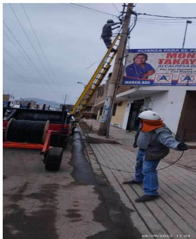
Figura 6: Tendido de óptica en la calle central de Quepepampa
