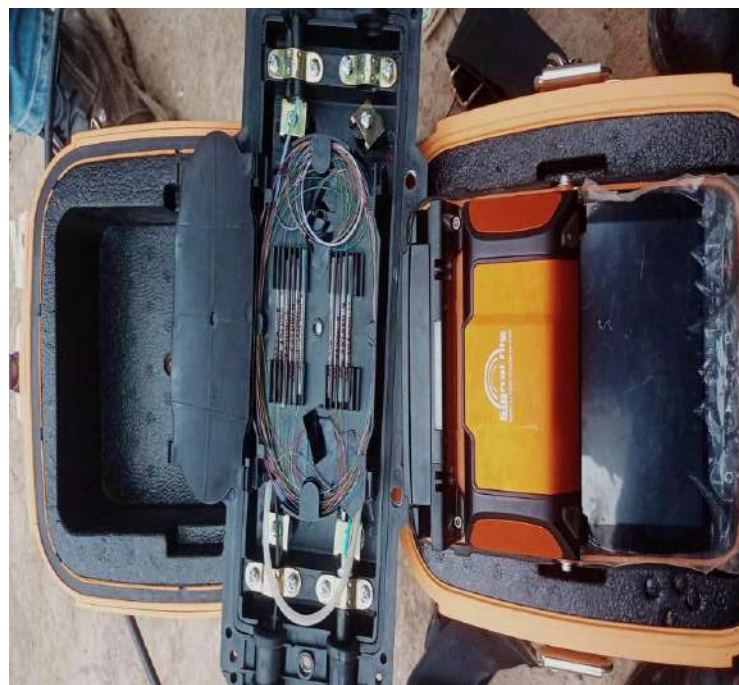
Figura 10: realizando fusiones en la mufa principal
