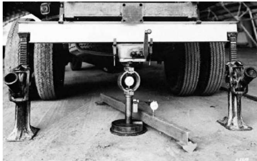
Figura 1 : Equipo para ensayos de California Bearing Ratio en campo.
