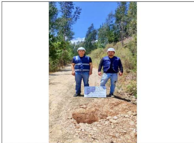
FOTOGRAFIA N°02: CALICATA N°02 Excavación de la calicata N°02 para el proyecto de tesis.
