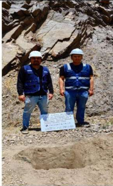
FOTOGRAFIA N°03: CALICATA N°03 Excavación de la calicata N°03 para el proyecto de tesis.
