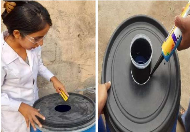
*Figura 13.* Corte de la parte central de la etapa del bidón y aplicación del Sikaflex.
