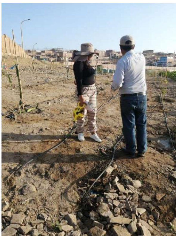
Figura 19. Instalación de sistema de riego
